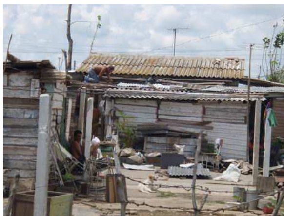
Aprovechar escombros para reconstruir
